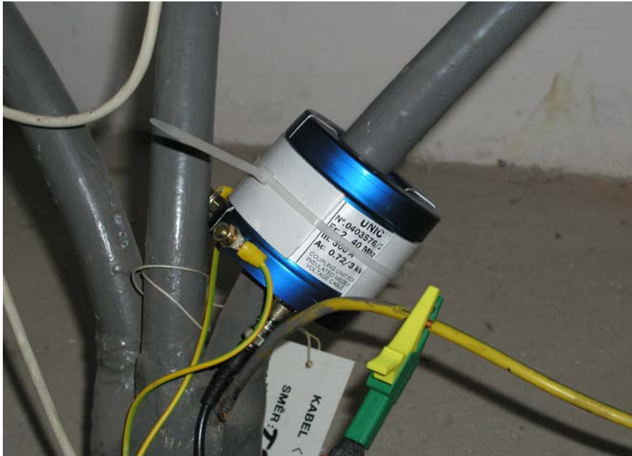
Induktivní vazební člen Eichhoff
