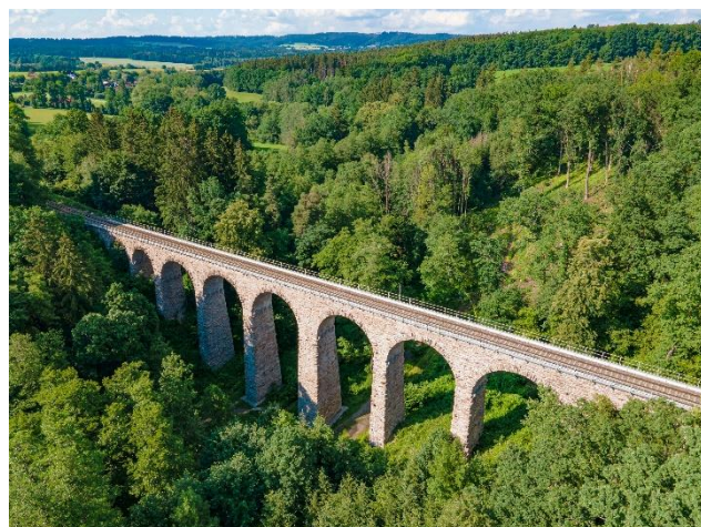
Železniční viadukt u Chýnova v okrese Tábor.
